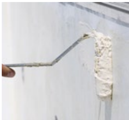
Filc se lijepi posebnim ljepilom
