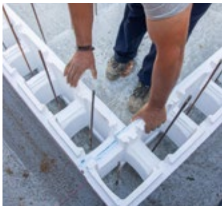
Postavljanje prvog reda stiropornih blokova
