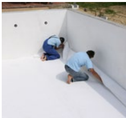
Ne preklapati filc na spojevima
