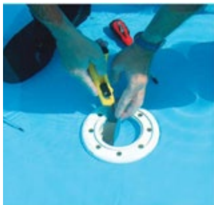
Izrezivanje folije nakon montaže priрубnice
