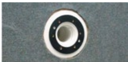
Precizno izrežiti filc oštrom nožem
