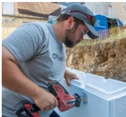
Priprema za izrez i montažu zida bazena
