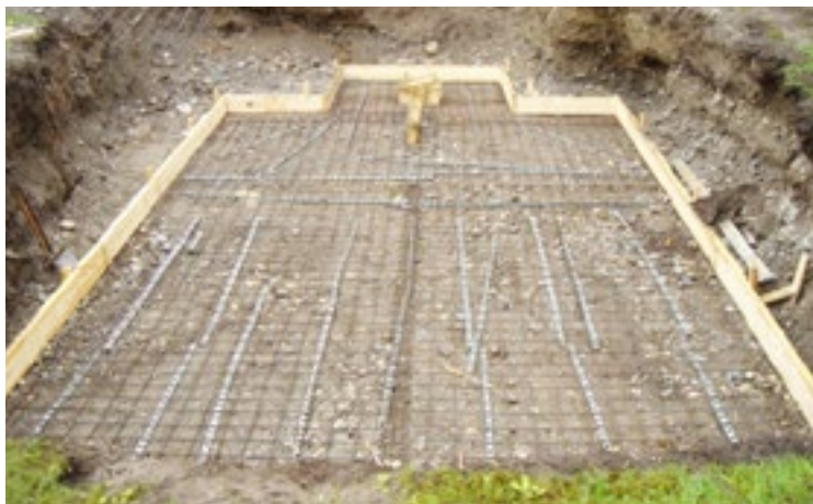
Montiranje i armiranje ploče
