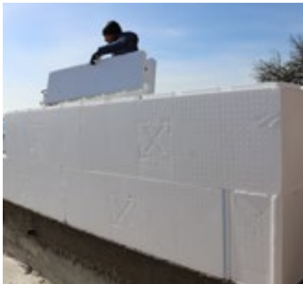
Vanjska strana stiropornih blokova
