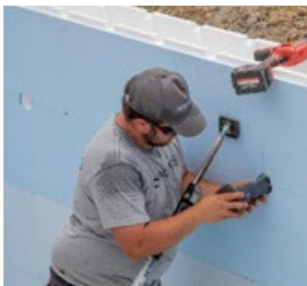
Stavljanje zidnog prolaza u stiroporni blok
