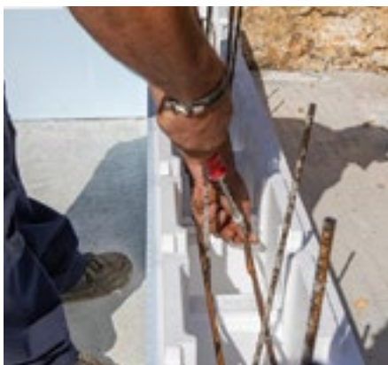
Blokovi imaju utor za polaganje horizontalne armature
