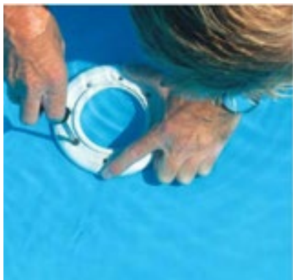
Pričvršćivanje priрубnice podnog ispusta
