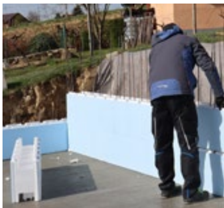
Postavljanje stiropornih blokova
