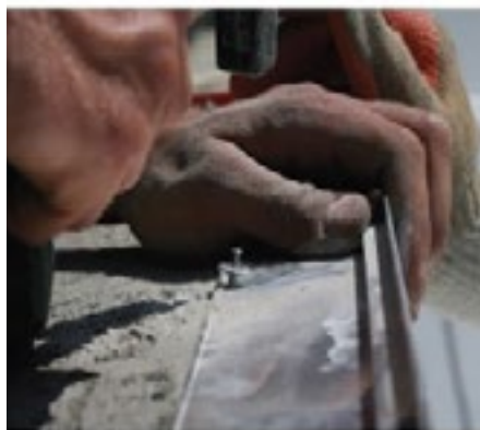
Pričvršćivanje profila zakucavanjem – zakovicama
