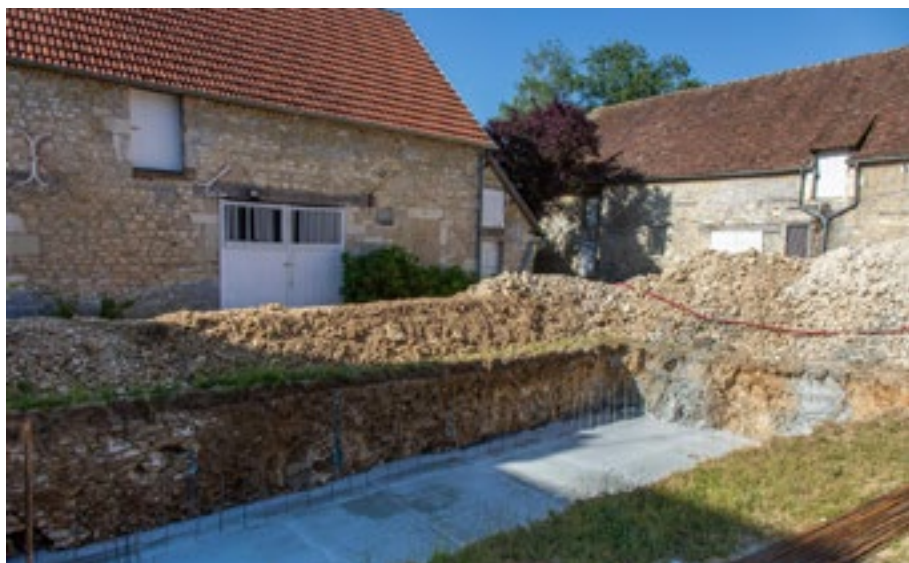
Završna obrada podne ploče
