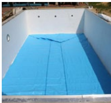
Postavljanje folije na dno bazena
