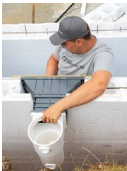
Postavljanje skimera u zid
